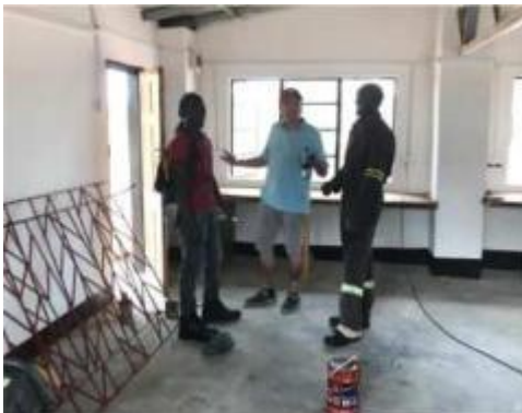
The AV room nearly finished
